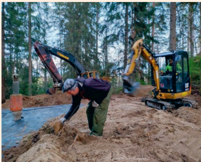
■ Kolmella kouralla yhtä aikaa! Taustalla Pertti Koivuaho peittää korsua 30-tonnisen kaivurin kouralla, oikealla Lauri Mikkonen 1,5-tonnisen kaivurin ohjaimissa ja etualalla 0,1-tonninen Janne Terkko näyttää pojille mallia. Projektin loppu alkaa hämmöttää.
