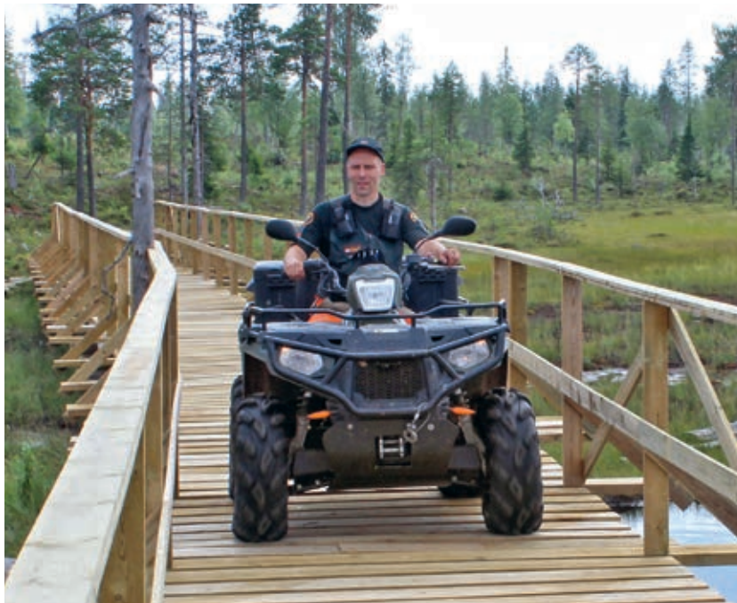
■ Valmistuneen kenttäsillan testausta, rajavartija ajaa mönkijällä yli valmista silttaa pitkin Suomussalmen Hossassa 2021
